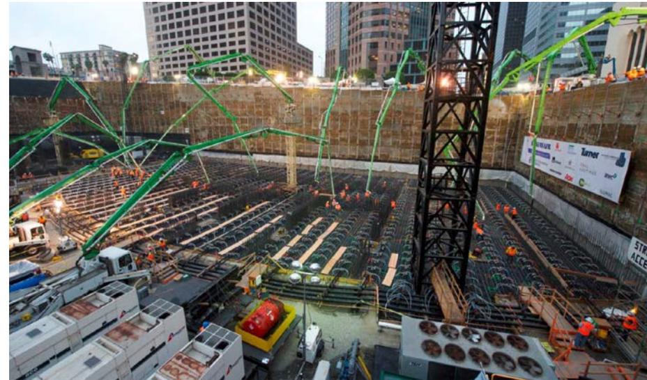
**Größte kontinuierliche Betonage** im Guinnessbuch der Rekorde – 16.200 m<sup>3</sup> Beton für die Bodenplatte für das New Wilshire Grand Center im Februar 2014 in Los Angeles
